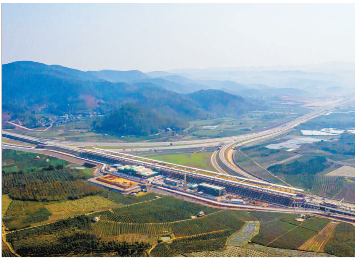
近期,中老昆(明)万(象)铁路国内段建设进展顺利,位于中老边境的友谊隧道建设进入收尾阶段,各车站土建工程基本完工,正线铺轨完成超过1/3。中老昆万铁路全长1000多公里,建成通车后,云南昆明至老挝万象有望夕发朝至。
