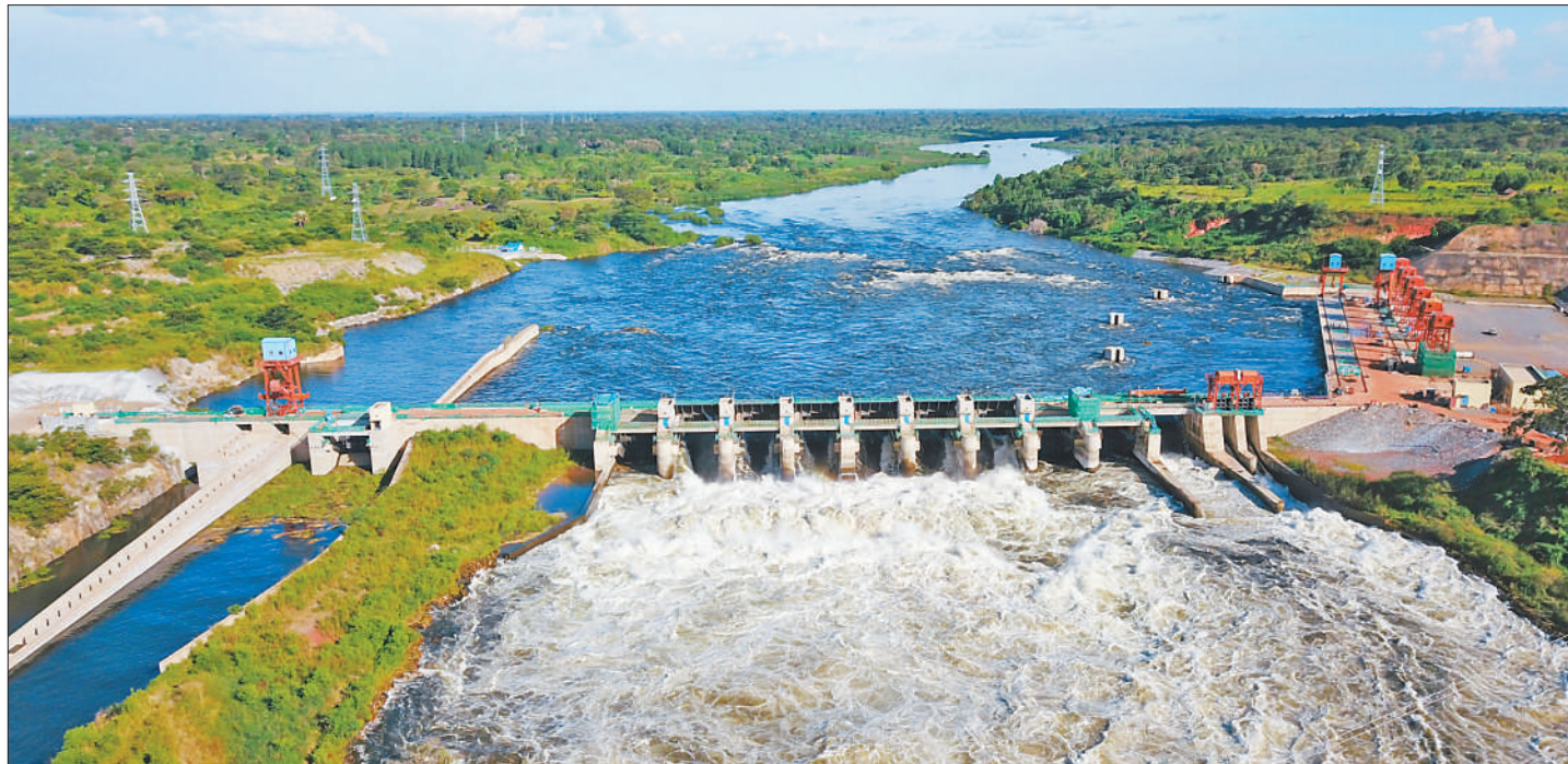
图为乌干达卡鲁玛水电站航拍全景。
