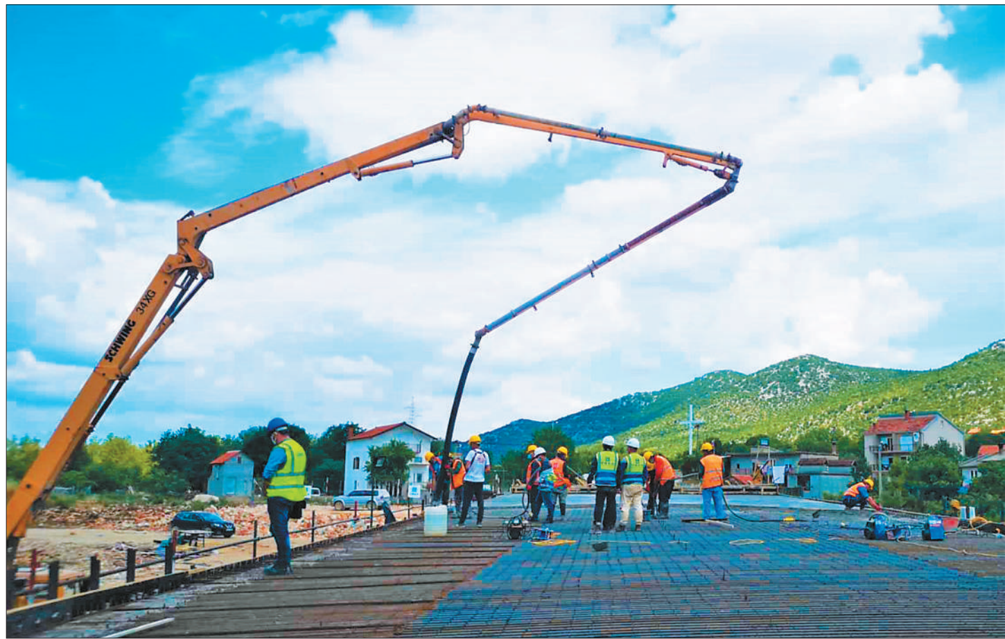
上图:波黑泛欧5C走廊高速公路第一标段项目施工现场。
