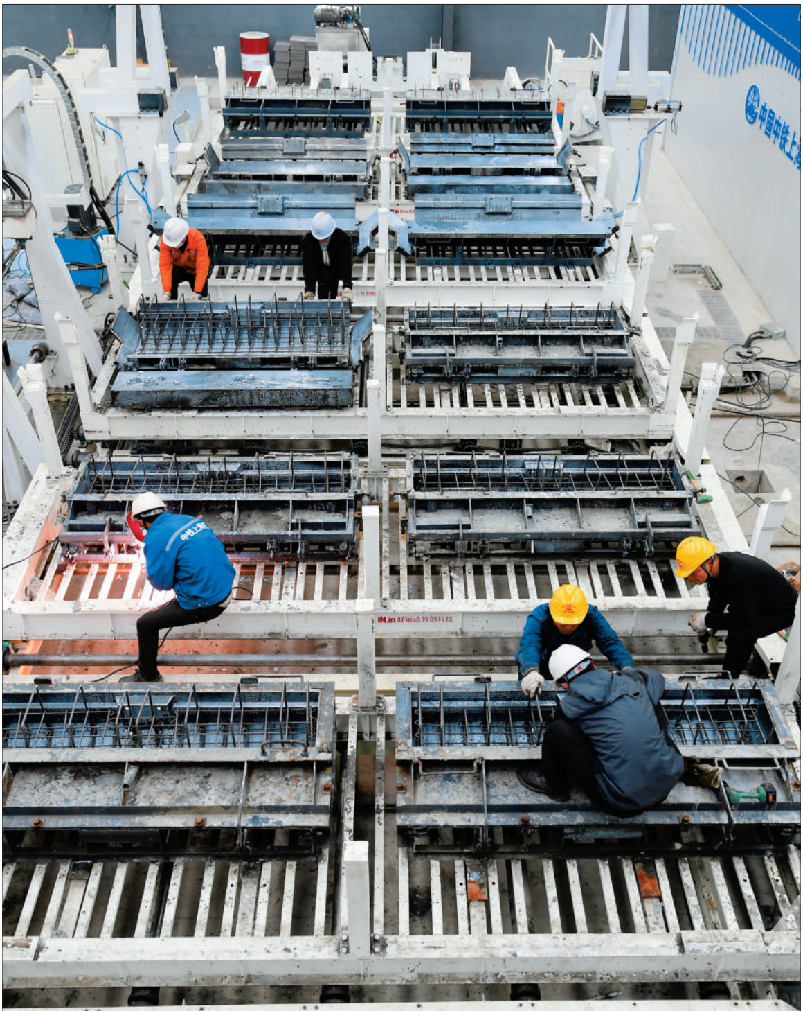
1月31日，江苏太仓小型预制构件厂，施工工人正在进行钢筋入模焊接、组架，为铁路小型预制构件浇筑做准备。南沿江城际铁路太仓梁场项目部30多名铁路建设者加班加点抢工期，保证建设项目顺利推进。
