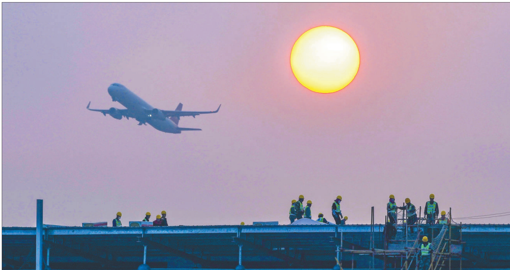
1月15日傍晚,海南海口美兰空港一站式飞机维修基地(一期)项目施工现场,工人们正在机库屋顶作业,一架客机从施工现场上空飞过。该项目建成后,将充分利用海南自贸港原辅料“零关税”等政策,形成多方位、多业务、多渠道、全产业链的国际一站式飞机维修产业集群。黄晓慧 王程龙 摄影报道
