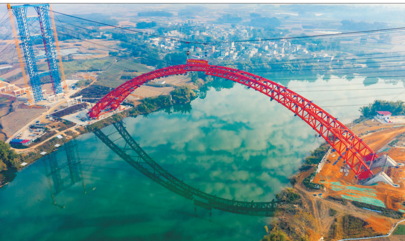
沙尾左江特大桥梁合龙
