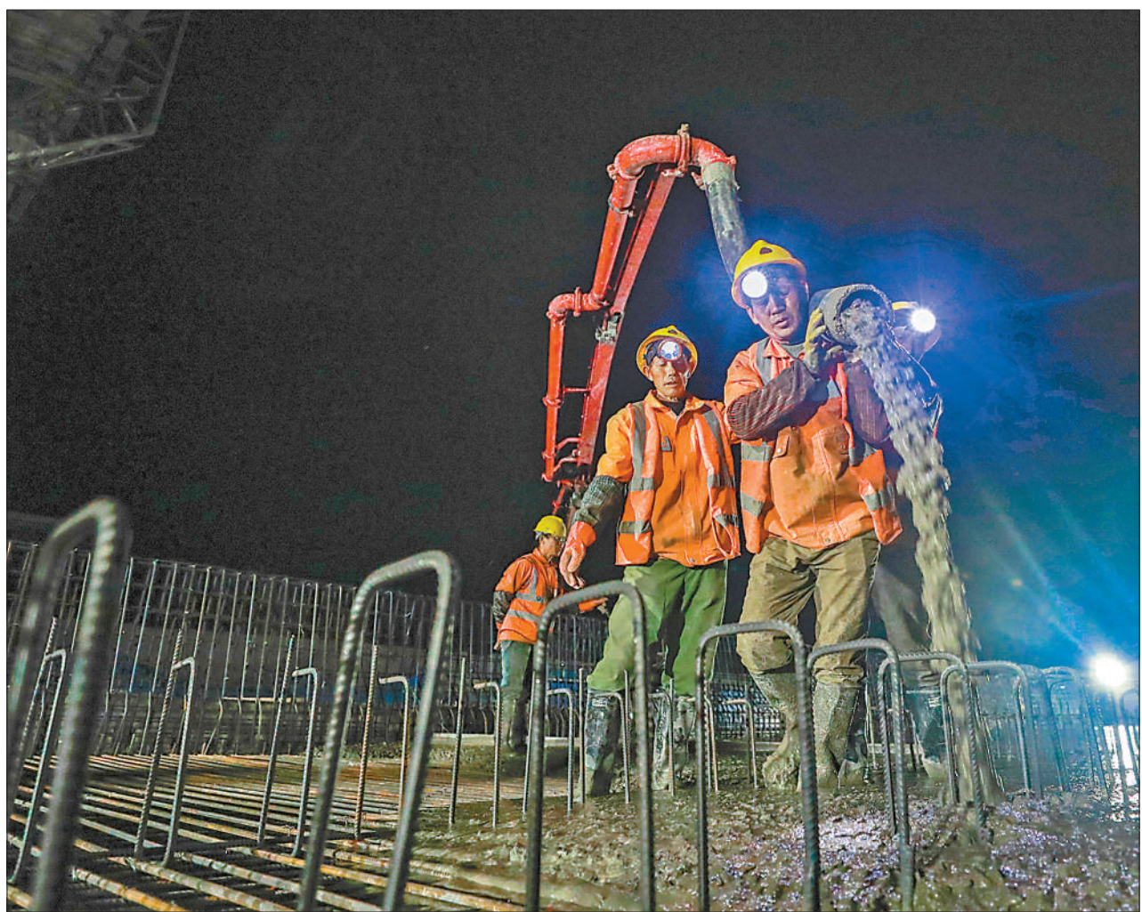
1月4日，江西鹰潭市鹰西南北通道工程下穿沪昆铁路白龙江大桥立交施工现场，工人在浇筑混凝土。该下穿立交项目建成后有效缓解当地交通压力；同时将保障沪昆铁路大动脉运输安全，为该区域未来发展提供有力保障。
