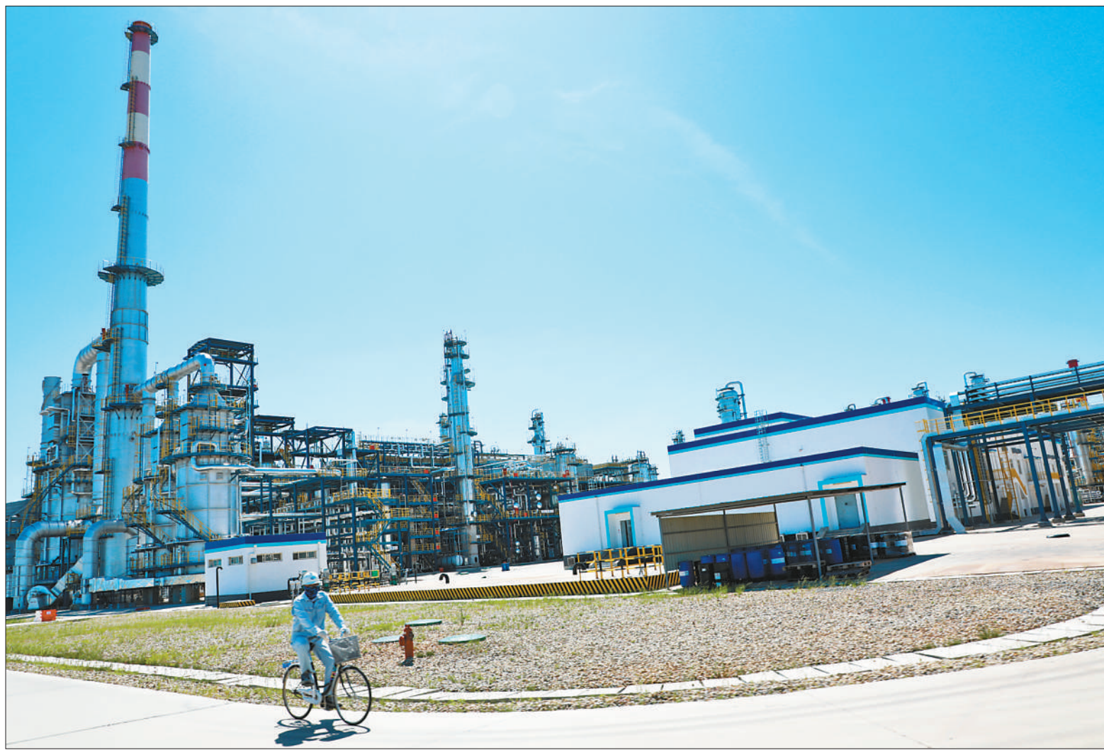
恒逸实业(文莱)有限公司大摩拉岛石化项目厂区一景。
