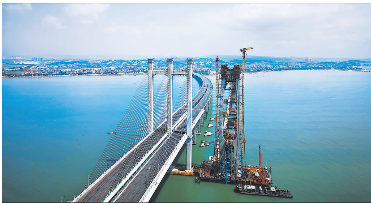
福厦高铁 泉州湾跨海大桥 南岸主塔封顶
